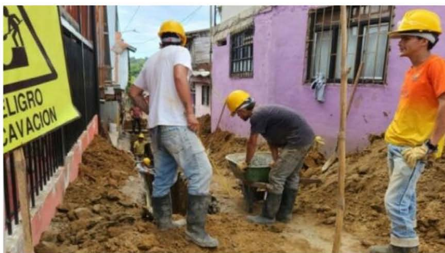
En pocos meses, habitantes del Centro Poblado La 18 contarán con un nuevo sistema de alcantarillado
